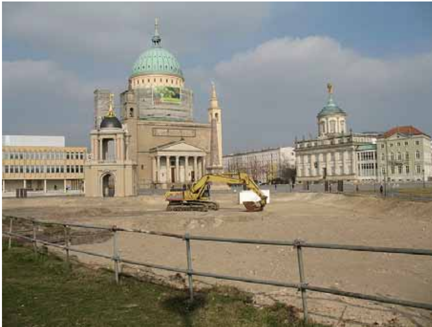
Das Fortunaportal in Potsdam mit den ersten Vorbereitungsarbeiten für den Bau des neuen Brandenburger Landtages, fotografiert von Florian S. (24.02.2008)
