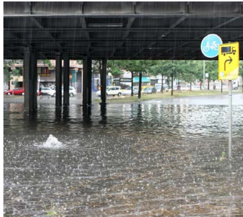
Abbildung 80: Überschwemmung Unterführung Wolfensteindamm, Berlin-Steglitz, 7.7.2006, 18.34 MESZ. Foto: GEORG MYRCIK in JANKIEWICZ/ MYRCIK/ WEHRY 2006: 2.
