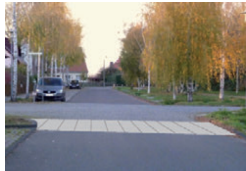
Abb. 16 und 17: oben: Aufpflasterung der Fahrbahn an einer Querungsstelle, unten: Aufpflasterung der Innenfläche eines Knotenpunktes, Quelle: H. Staadt (2012).
