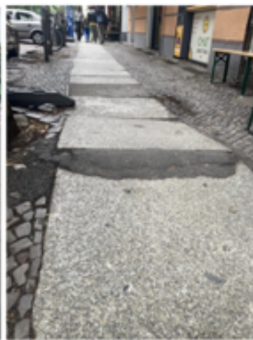
∧ Angehobene Pflasterfläche
